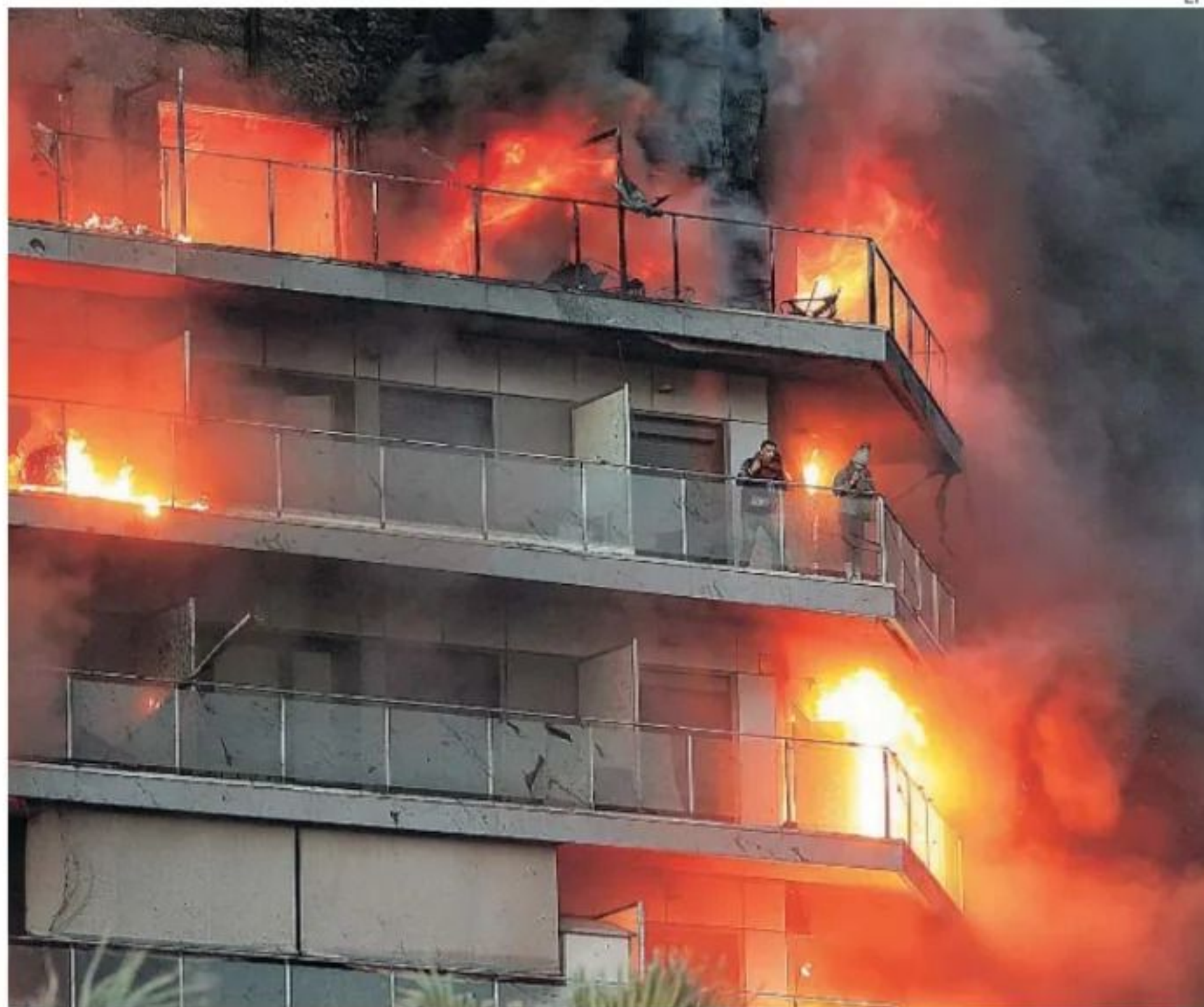
El fuego se propagó con rapidez debido al material inflamable de la fachada
